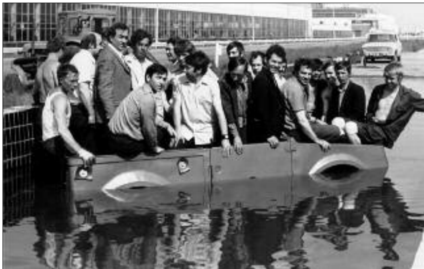
Проверка первого кузова амфибии на герметичность в глубоководной ванне трека ВАЗа (весна 1976 г.).
