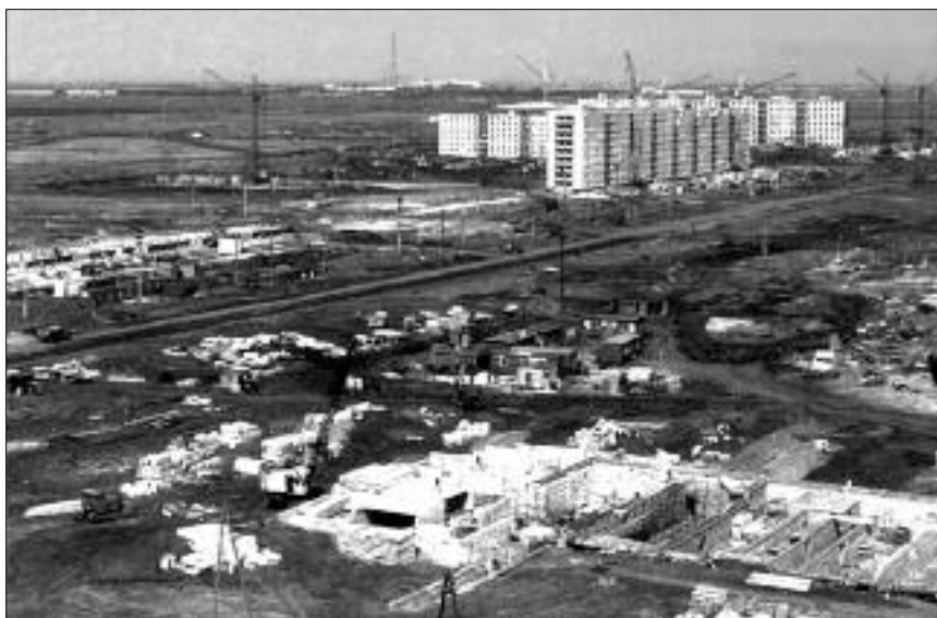
Лето 1969 года. Строительство Нового города велось полным ходом.
