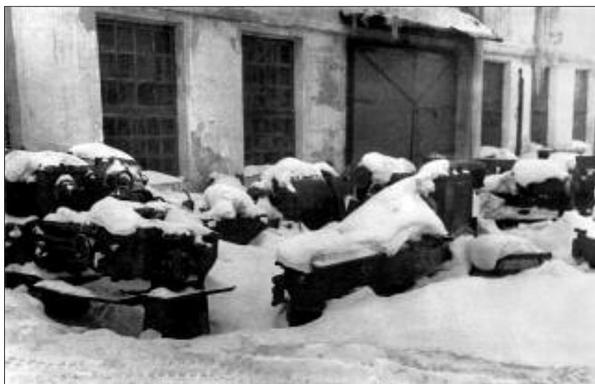
Ремонтно-механический цех Магаданского механического (бывшего авторемонтного) завода. Станки с приисков ждут ремонта.
