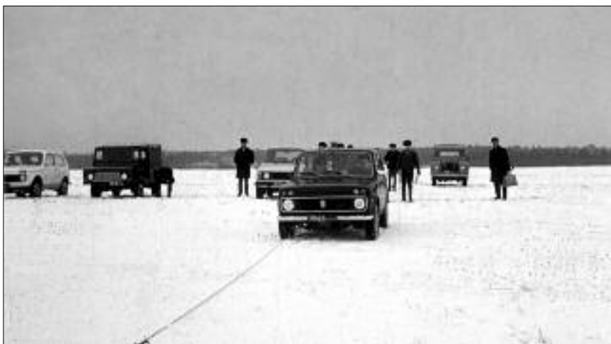
Практически вся команда в сборе (испытания на проходимость, автополигон). Определяется сопротивление движению на плотном марттовском снегу (виден трос тяговой лебёдки). На заднем плане — вторая "Нива", "Волынь", ИЖ-14 и "Лэнд Ровер 88".
