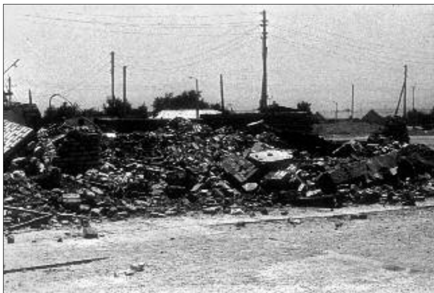
Поселок Газли ещё не оправился после недавнего сильного землетрясения. Руины вместо домов, глубокие трещины в асфальте.
