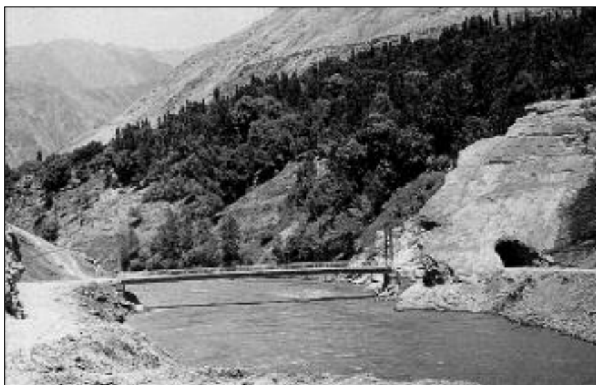
Уникальный висячий мост через бурный Зеравшан в районе кишлака Айни. Первый въезд на мост выдолблен прямо в скале.
